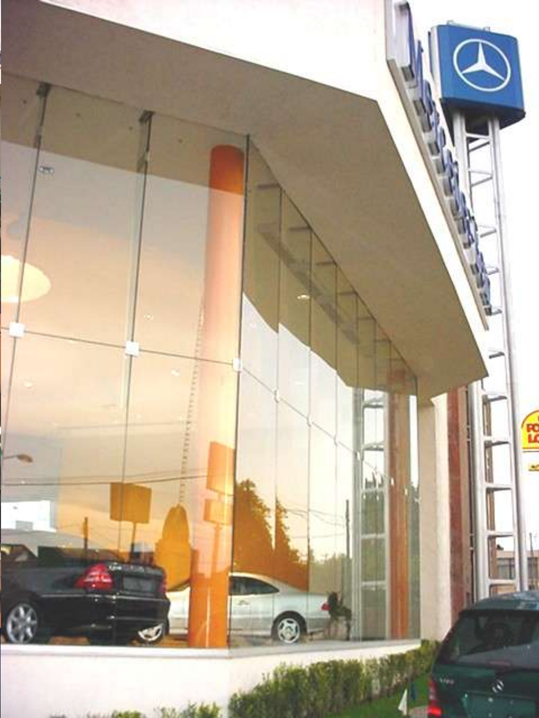
Agencia Mercedes-Benz Villauto Fachada Suspendida Línea 5800. Saltillo, Coahuila
