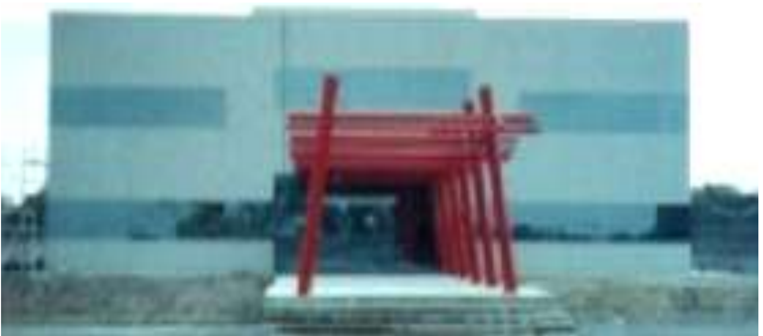
TRANSPORTES MOR FACHADAS CON REFLECTASOL 6 MM
