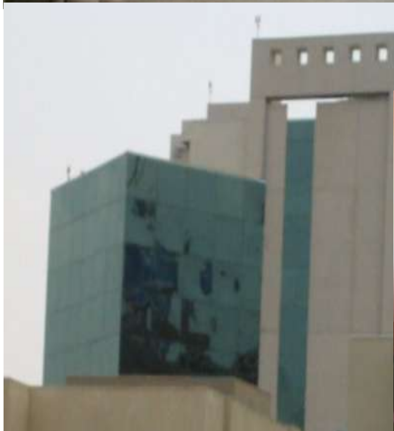
HOSPITAL SAN JOSE DUO VENT TINEX REFLECTASOL + CLARO TEMPLADOS INCLUYENDO PERSIANA EN EL INTERIOR DE VENTANAS
