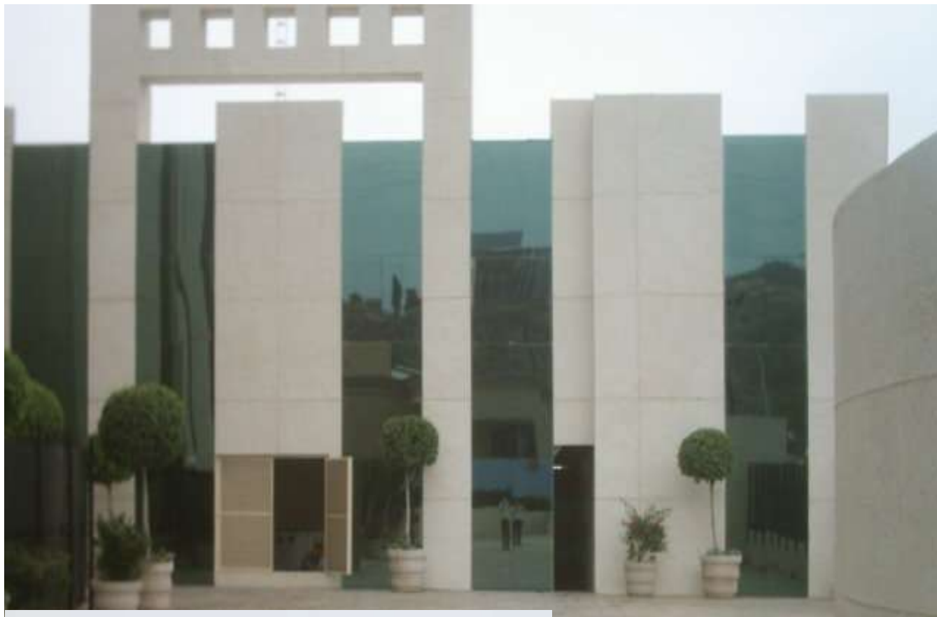
HOSPITAL SAN JOSE DUO VENT TINEX REFLECTASOL + CLARO TEMPLADOS INCLUYENDO PERSIANA EN EL INTERIOR DE VENTANAS
